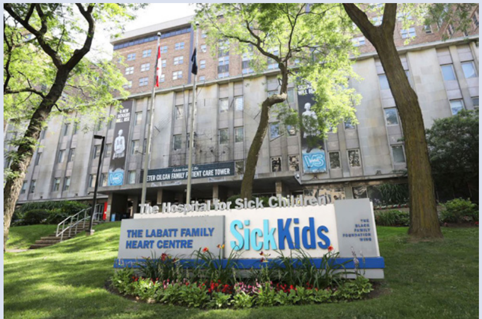
Abb. 1: Alter Zugang und Ansicht über University Avenue
