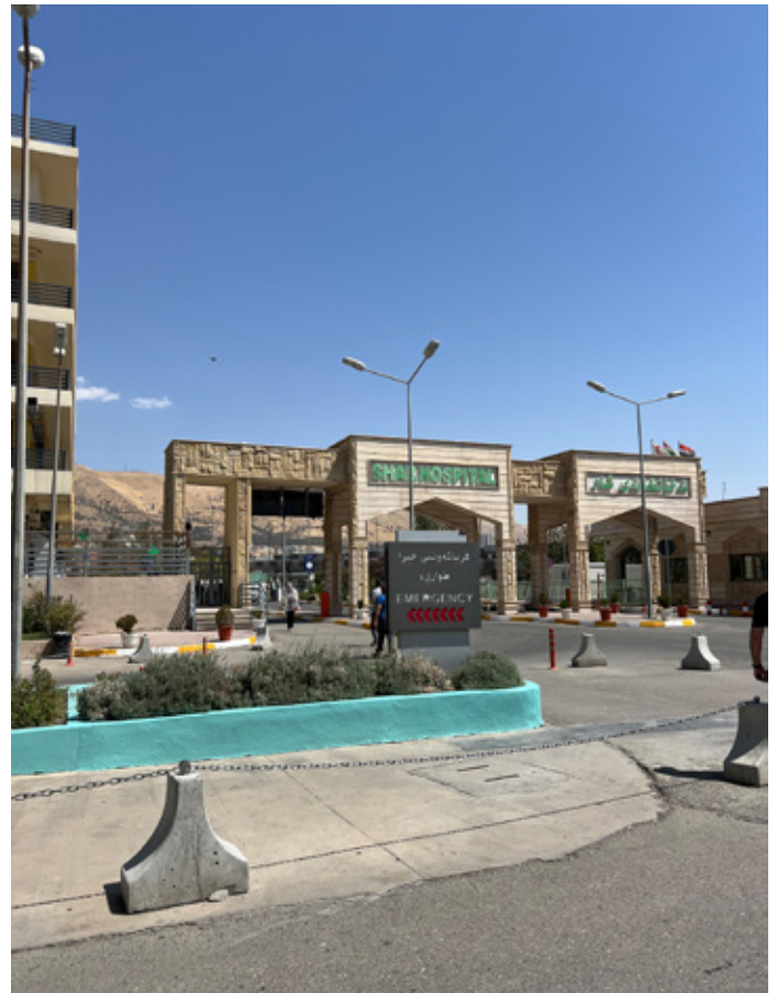
Abb. 2: Shar Hospital Eingang
